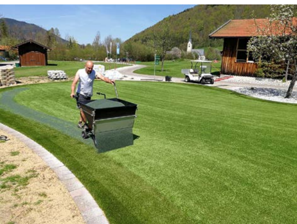
Einarbeitung Topdress in 3 Schichten
